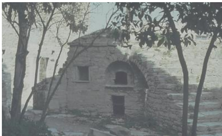
Εικ. 5. Φούρνος με κενό στο κάτω μέρος, στην οικία Πάτσαλου στα Πάνω Λεύκαρα.
