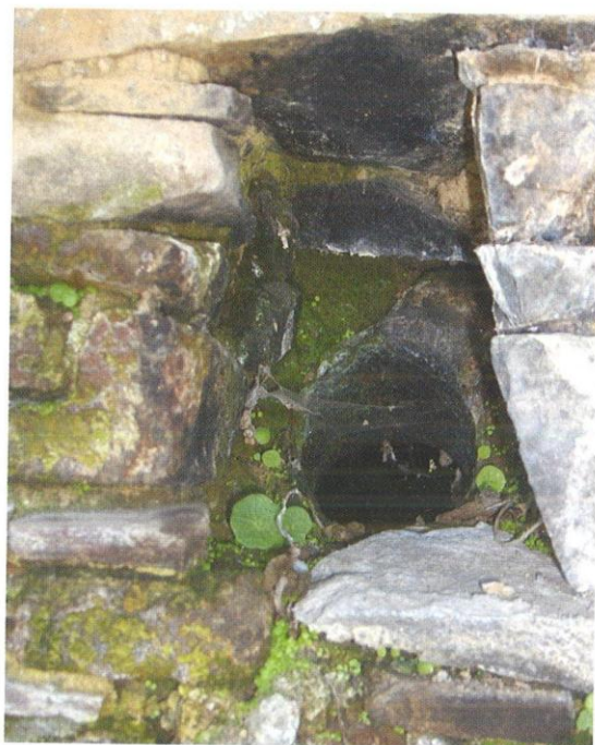
Η κατασκευή του φούρνου
